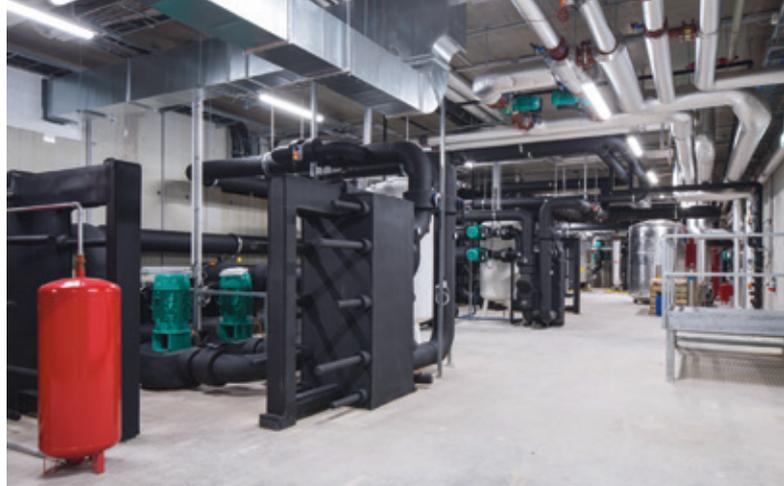
nachvollziehbaren und gesicherten hydraulischen Schaltungen erfolgen kann. „Wir wollen wissen, wann wohin und wie viel Energie fließt.“ Darum kamen im ersten Schritt 78 druckunabhängige Regelventile mit Durchfluss- und Energie-Monitoring von Belimo, sogenannte „Energy-Valves“, zum Einsatz.
